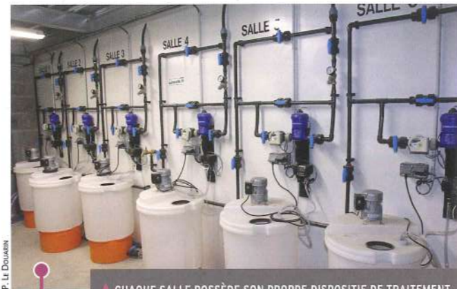
▲ CHAQUE SALLE POSSÈDE SON PROPRE DISPOSITIF DE TRAITEMENT DE L'EAU, avec notamment une pompe doseuse proportionnelle connectée qui renseigne sur tous les événements (débits, ruptures...).
